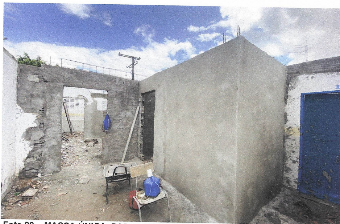
Foto 06 – MASSA ÚNICA, PARA RECEBIMENTO DE PINTURA, EM ARGAMASSA
