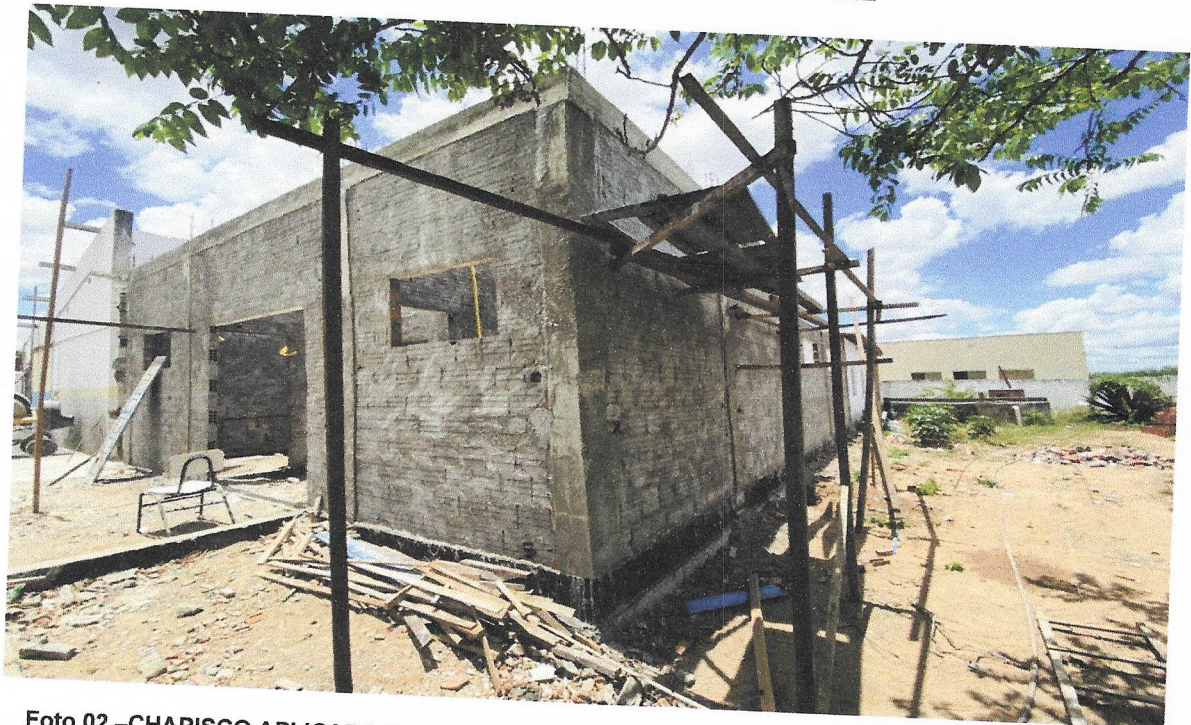
Foto 02 –CHAPISCO APLICADO EM ALVENARIAS E ESTRUTURAS DE CONCRETO INTERNAS, COM COLHER DE PEDREIRO.
