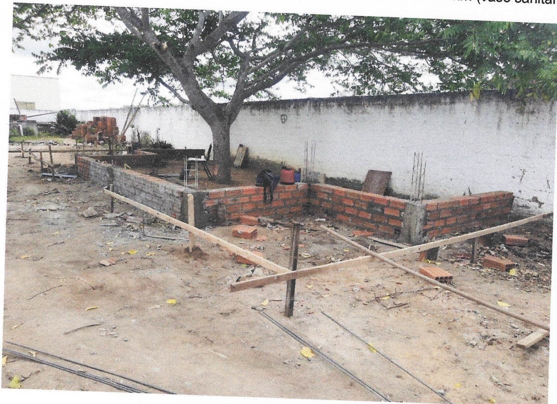
Foto 24- ALVENARIA DE VEDAÇÃO DE BLOCOS CERÂMICOS FURADOS NA VERTICAL DE 9X19X39 CM
