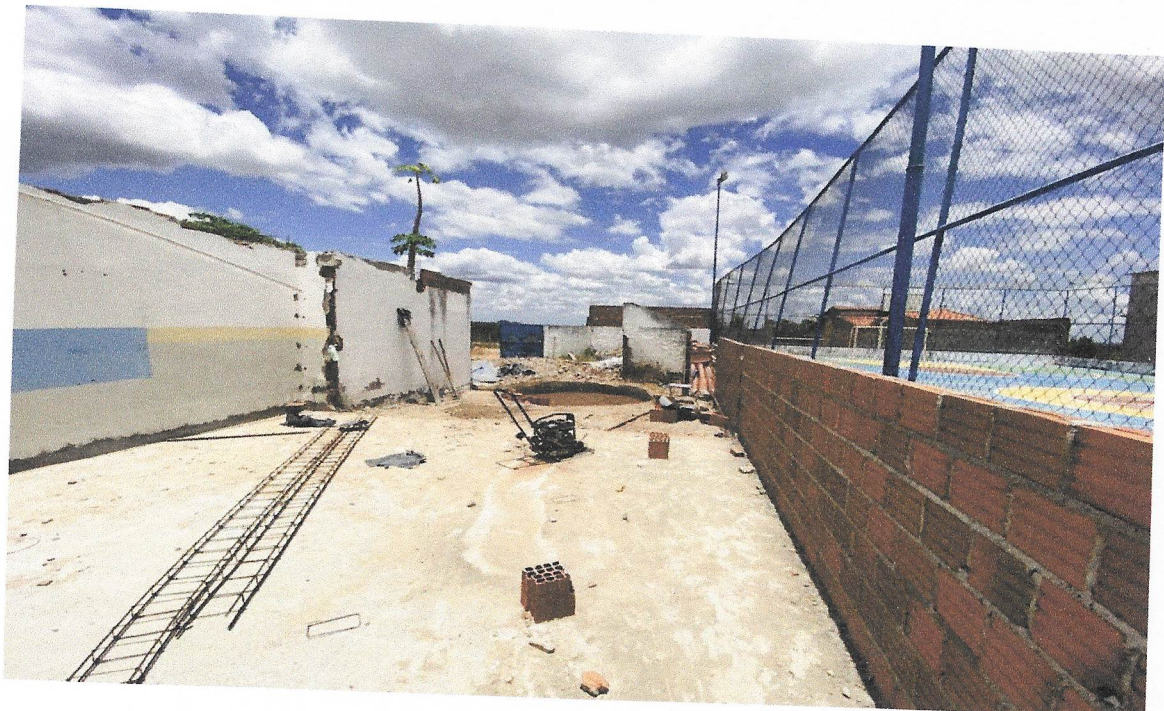
Foto 10 – ALVENARIA DE VEDAÇÃO DE BLOCOS CERÂMICOS FURADOS NA HORIZONTAL DE 9X19X19CM (ESPESSURA 9CM)
