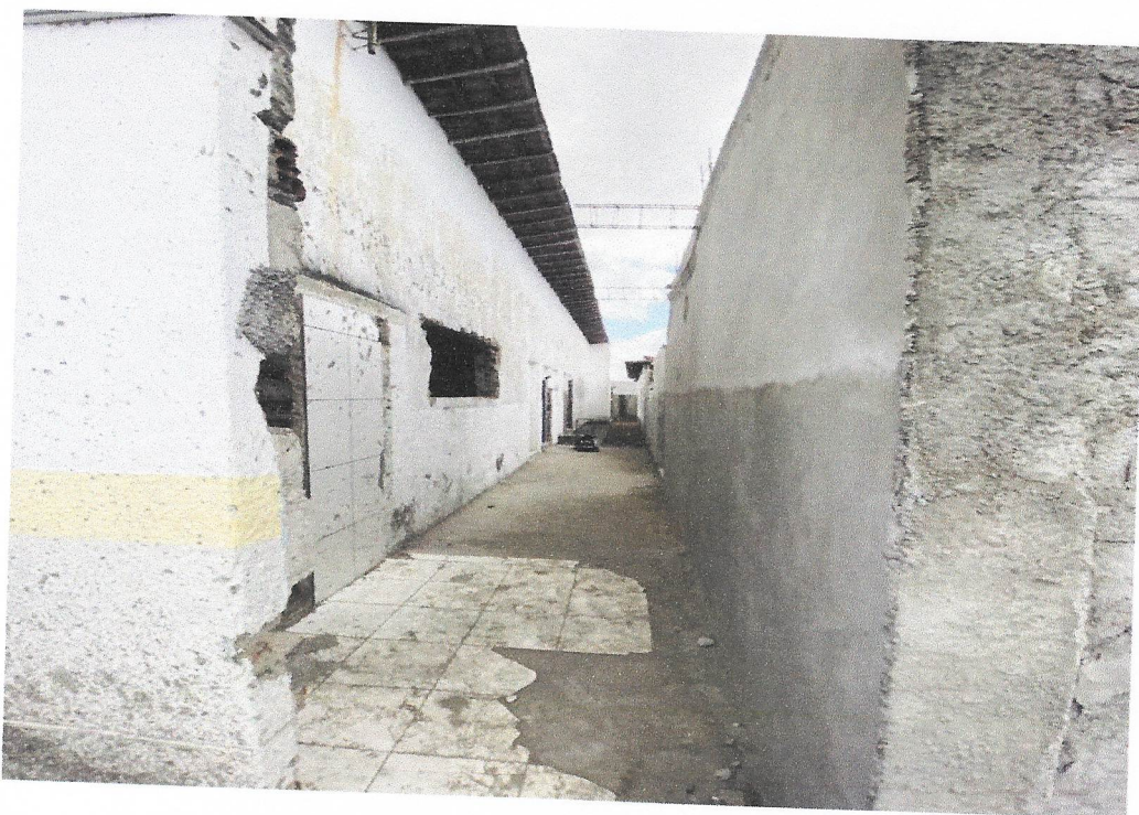
Foto 04 – MASSA ÚNICA, PARA RECEBIMENTO DE PINTURA, EM ARGAMASSA
