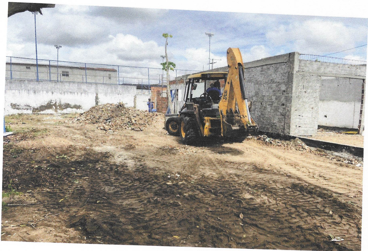
Foto 12- REGULARIZAÇÃO DE SOLO PREDOMINANTEMENTE ARENOSO
