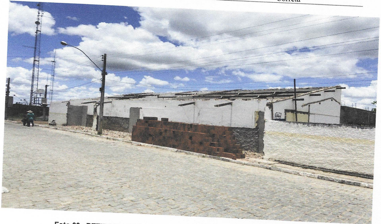
Foto 09 –RETIRADA E RECOLOCAÇÃO DE TELHA CERÂMICA CAPA-CANAL
