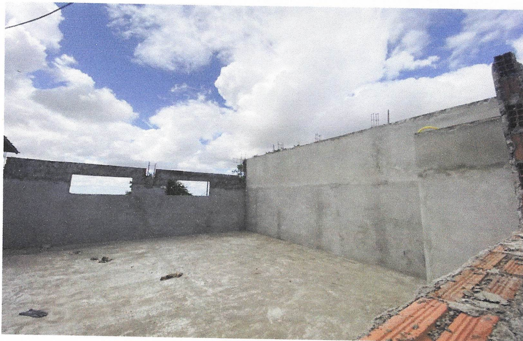
Foto 05 – MASSA ÚNICA, PARA RECEBIMENTO DE PINTURA, EM ARGAMASSA
