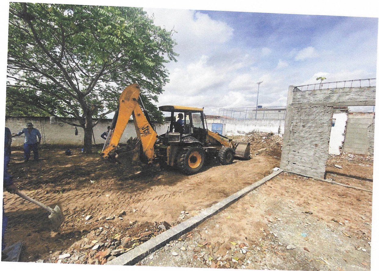
Foto 14- Foto 12- REGULARIZAÇÃO DE SOLO PREDOMINANTEMENTE ARENOSO
