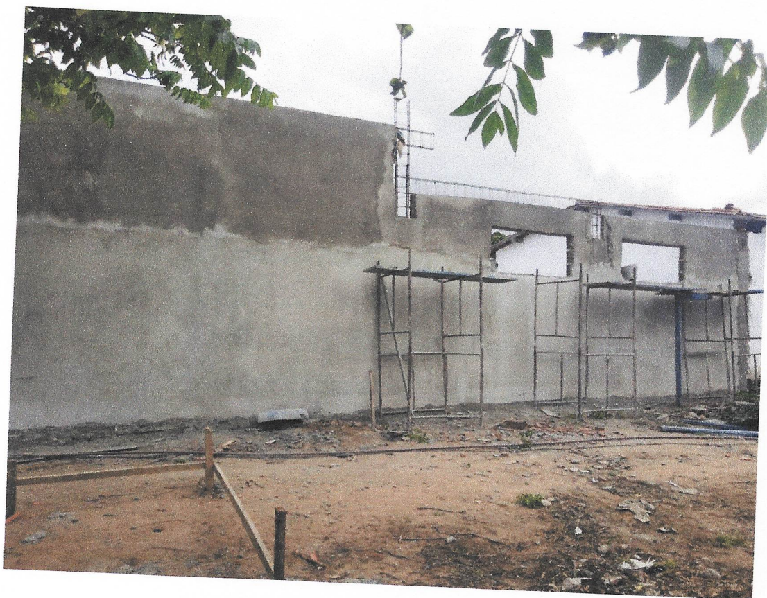
Foto 26 - EXECUÇÃO DE MASSA ÚNICA.
