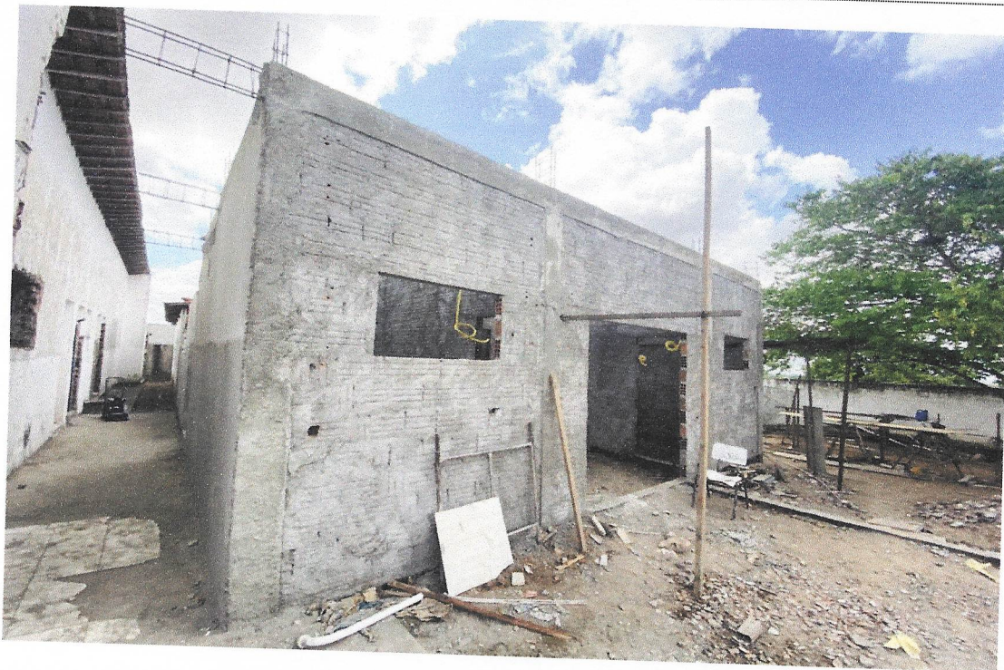
Foto 03 – CHAPISCO APLICADO EM ALVENARIAS E ESTRUTURAS DE CONCRETO INTERNAS, COM COLHER DE PEDREIRO.
